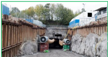
Verfugung der Oberfläche und des Tunneleingangs
